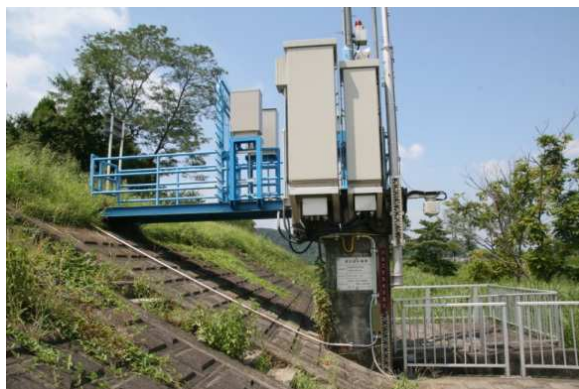
草花排水樋管
