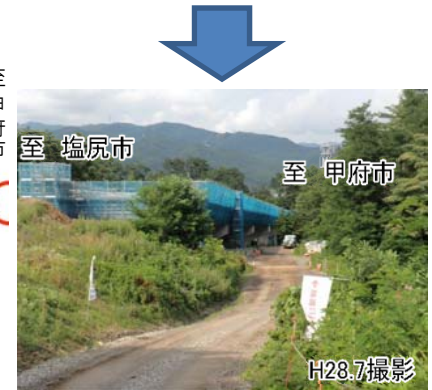
② 塩嶺大橋 上部工事の状況
