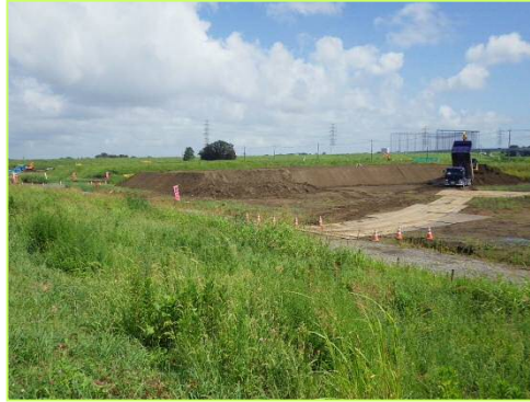
流山建設発生土トラック南地区、生産土量約5,100m 3 の仮置き状況
