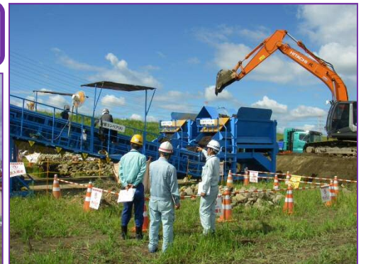
H27江戸川管内土砂改良工事万能土質改良機の工事安全パトロール状況
