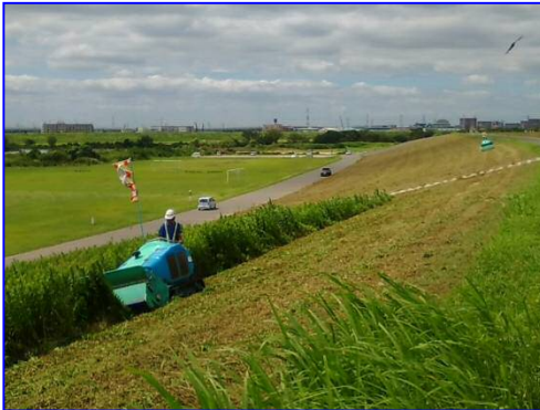
江戸川左岸22.0k付近川表法面除草
