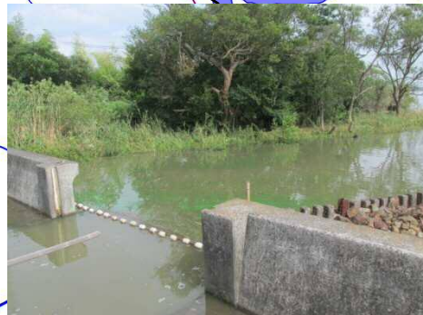
8/24 右岸47.75k付近 蓮河原舟溜り付近 (レベル2～3)
