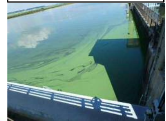
8/4 常陸川左岸0.5K+70m 常陸川水門付近(レベル3)
