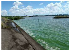
7/29 左岸28.25K+100m 付近(レベル3)
