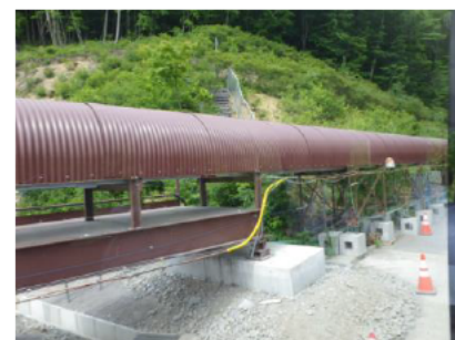
ベルトコンベアの設置状況
