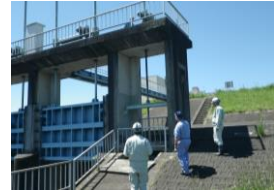
樋管の履行検査状況
