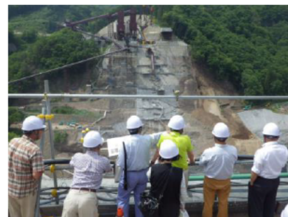
「基礎掘削状況」を見ている様子
