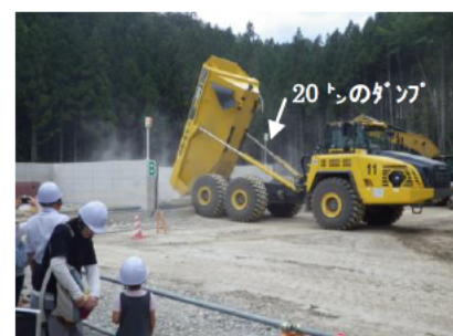
「骨材」ラットヤード」に石を投入している様子
