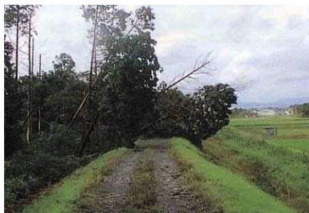
倒木により堤防へ影響
