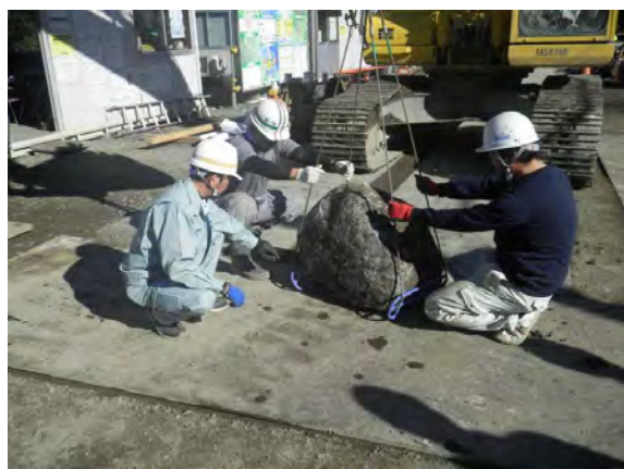
巨石吊り具の工夫
