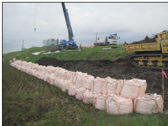
平成26年10月台風18号出水での漏水発見に伴う緊急対応状況
