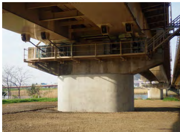
千住新橋下り P4橋脚
