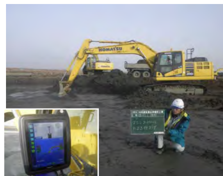
インテリジェントマシンコントロール油圧ショベルによる掘削
