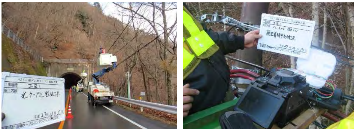
完成又は施工状況写真
