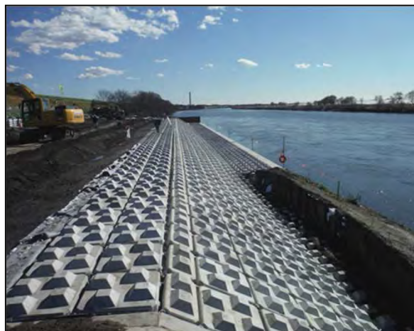
大型連結ブロック据付施工状況
