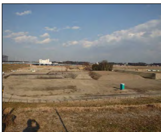
完成(改良土生産完了)
