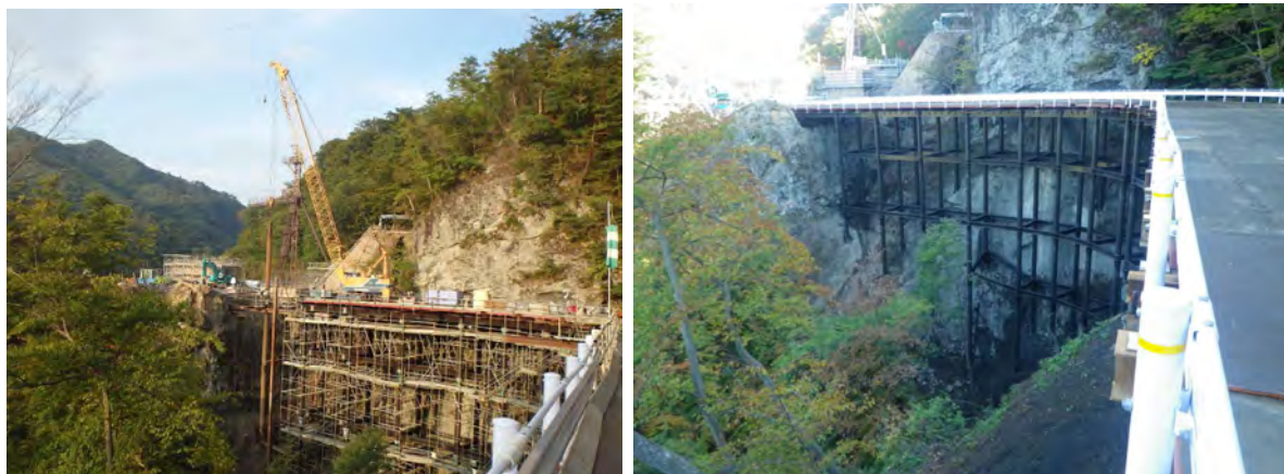
完成又は施工状況写真
