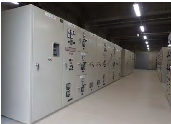
高圧受変電設備
