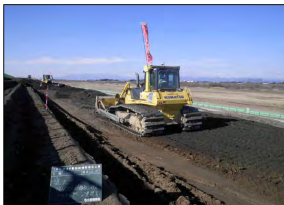
【GNSS締固め管理システム施工状況】
