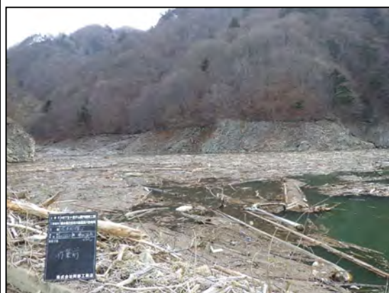
流木処理工(施工前)
