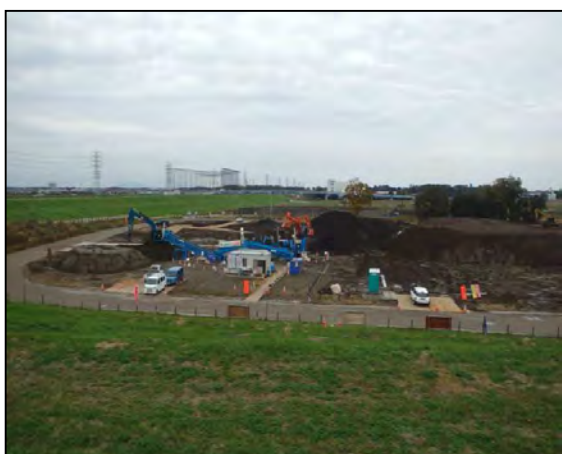
土砂改良施工状況
