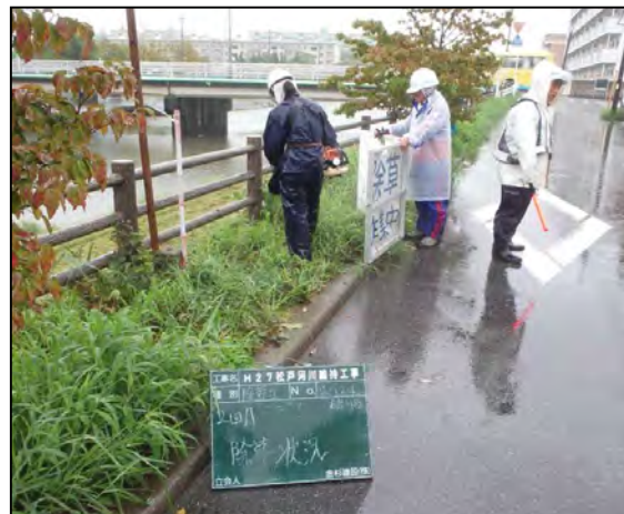
堤防除草作業
