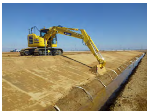
施工状況(情報化施工による法面整形)
