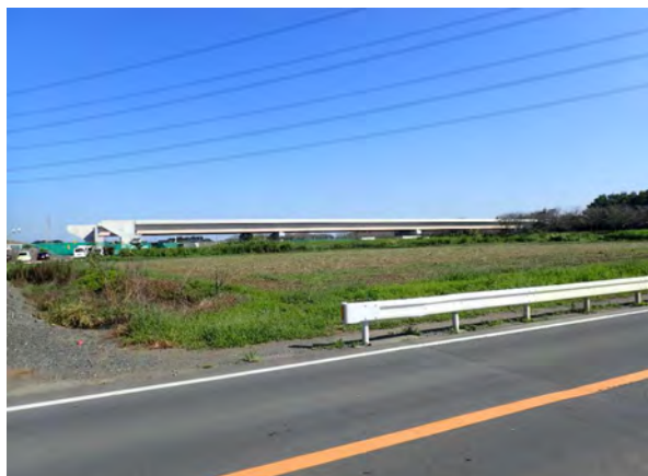
完成状況(全景)
