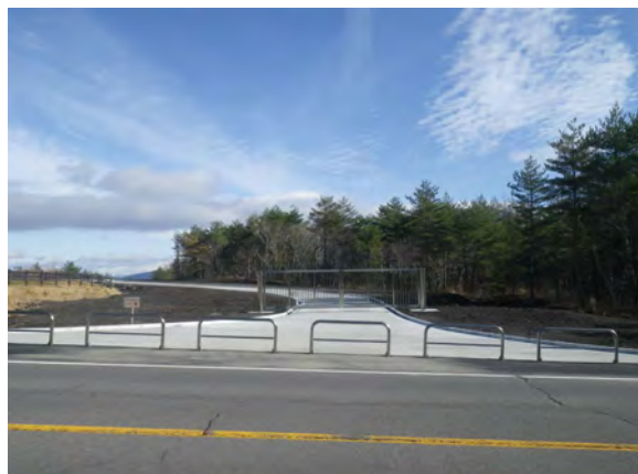
片蓋川幹線工事用道路(終点側)完成写真
