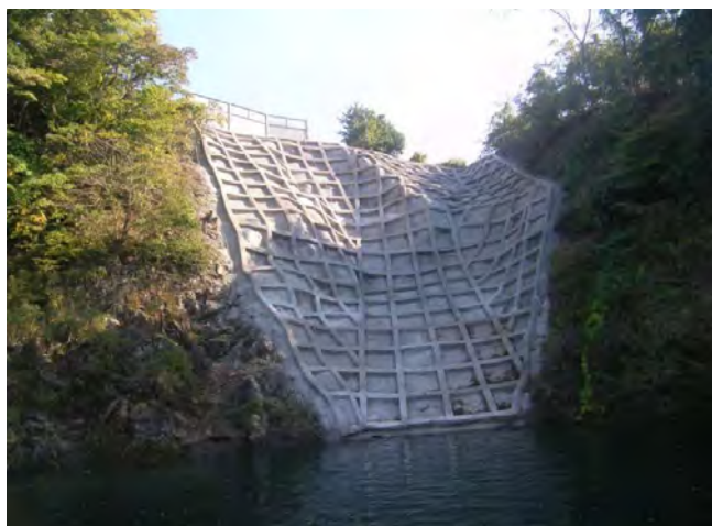
完成又は施工状況写真
