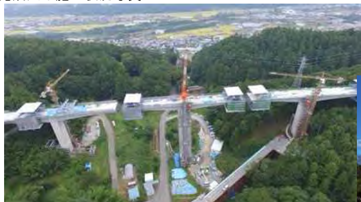
桁の架設状況
