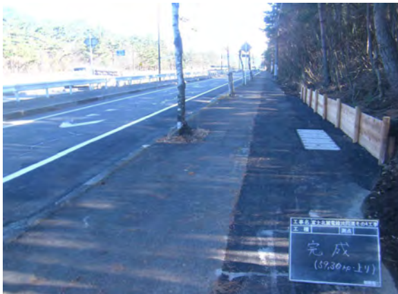
工事完成状況
