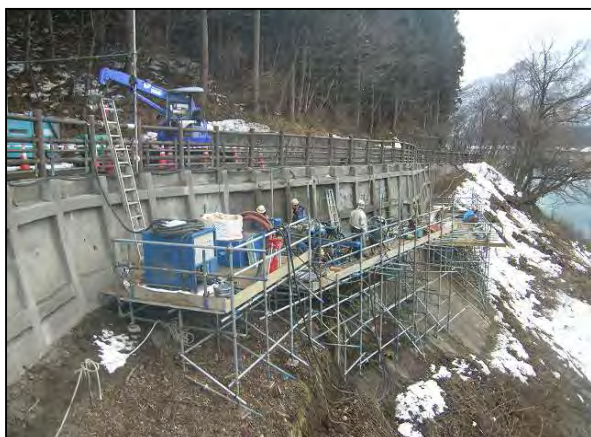
法面工(施工中)
