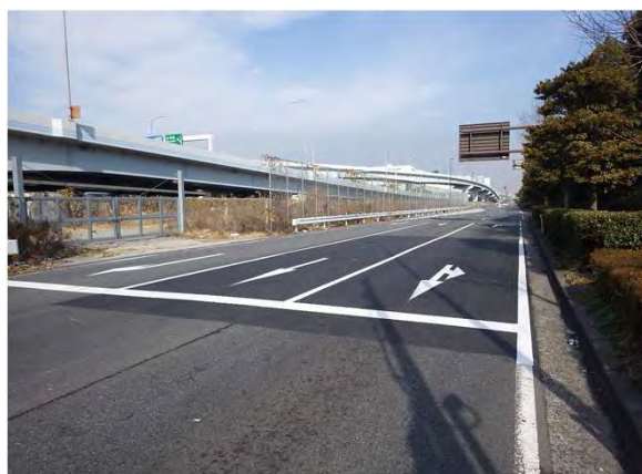
路面補修(パッチング)
