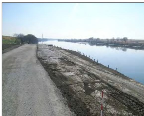
完成(覆土完了)
