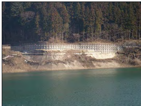
法面工(施工後)
