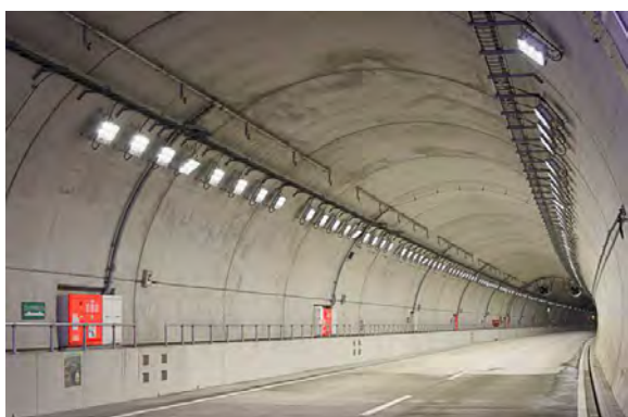
消火設備・スプリンクラー設備
