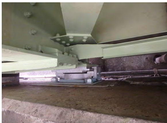
完成又は施工状況写真
