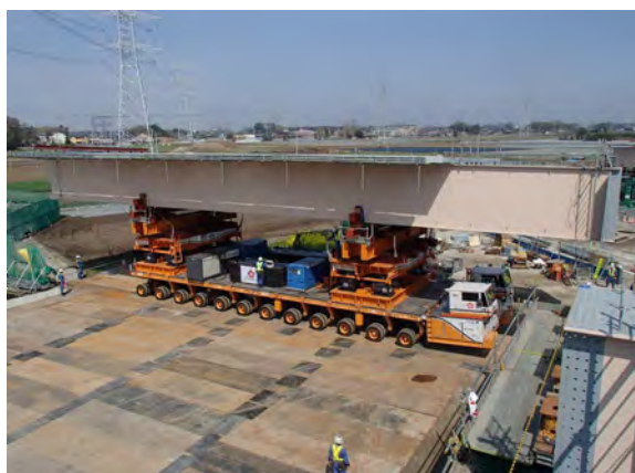
一括架橋状況(箱桁及び合成床板)
