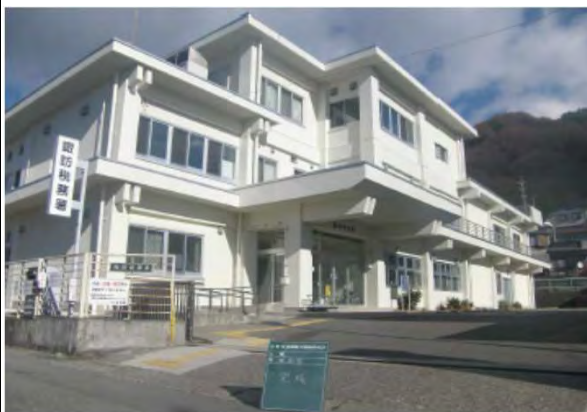
完成又は施工状況写真
