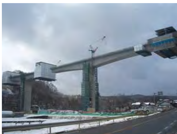
桁の架設状況
