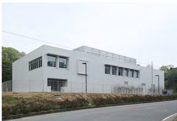
完成又は施工状況写真
