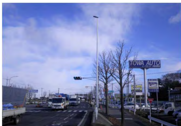
完成又は施工状況写真
