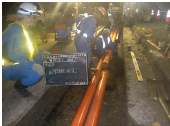
管路敷設状況
