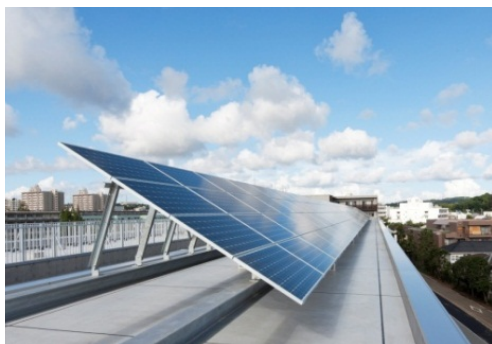
太陽光発電設備の例
