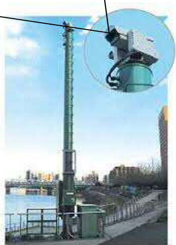
監視用カメラの増設
