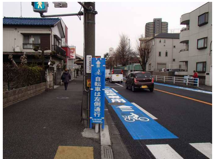
図-9 自転車通行空間啓発用看板の設置状況
