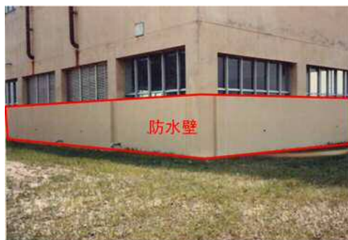
機場建屋の浸水対策を実施
