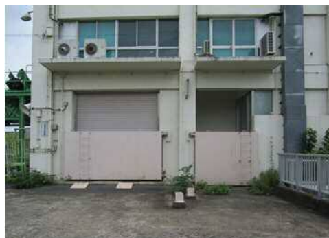
入口にゲートを設置
