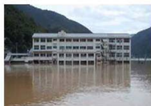
H26.8避難所2階の浸水 (徳島県)
