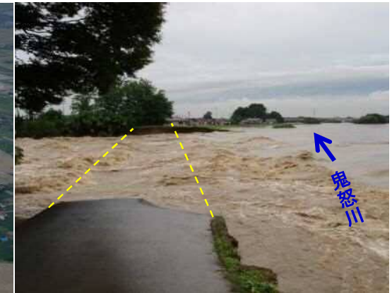
被災状況(拡大写真)
