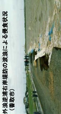
外浪逆浦右岸堤防の波浪による侵食状況(香取市)
