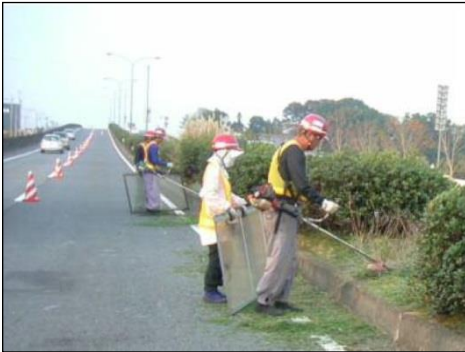
中央分離帯や歩道の植樹帯は、作業範囲が狭隘なため、効率が悪い
