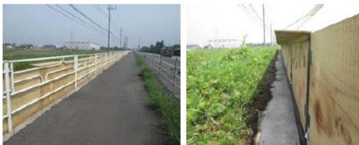
板張りの遮陽壁による雑草繁茂対策事例 雑草の抑制対策をH26年度より試行的に実施
