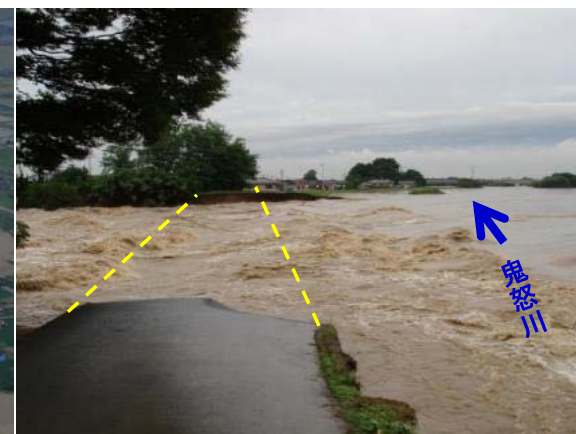
被災状況(拡大写真)
