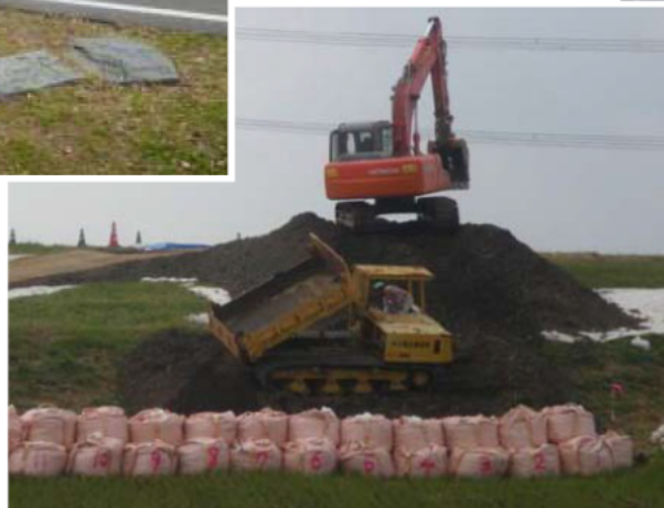
建設業者による水防支援 (イメージ)
