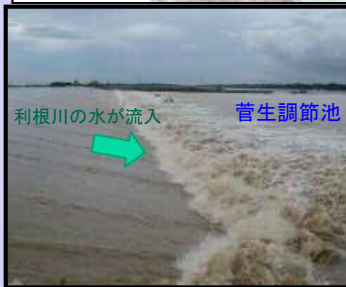
◀利根川の水が越流堤を超えて菅生調節池に流入している状況
