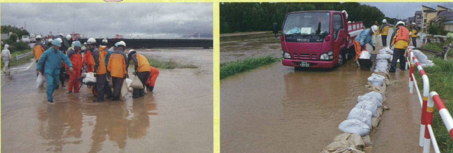
浸水被害を軽減するため、懸命に土のうを積む桂川・小畑川水防事務組合の水防団員ら
