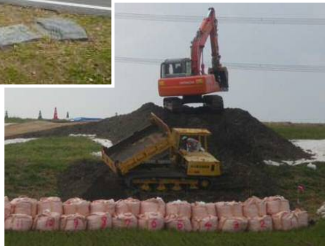
建設業者による水防支援 (イメージ)
