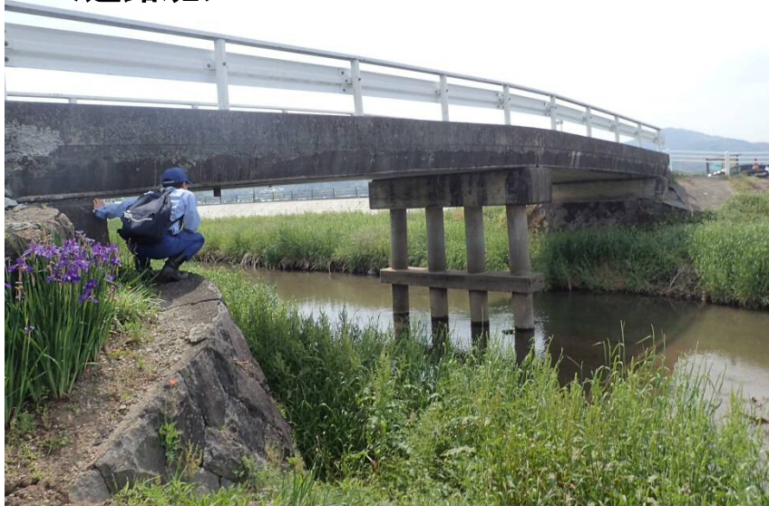
ましきまち 〈道路班〉 【橋梁被災状況調査(益城町)】
