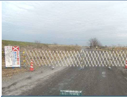
①車両進入防止バリケード
