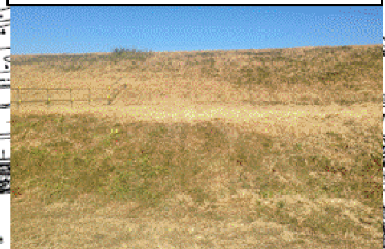
⑥法面の柵を天端から越えている
