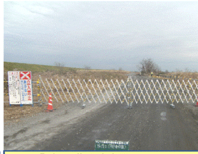
①車両進入防止バリケード
