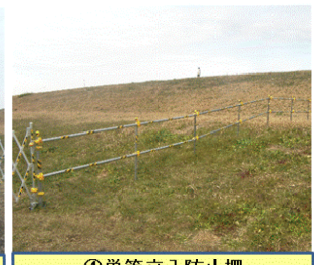
④単管立入防止柵
