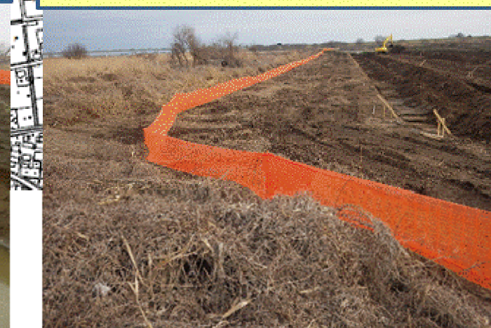
⑤工事エリア侵入防止オレンジネット
