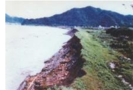
身延町波木井地先の堤防洗掘
