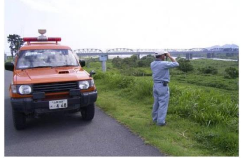
河川巡視状況(平常時)
