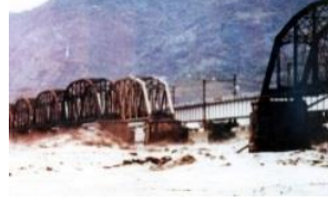
東海道本線鉄橋の流失
