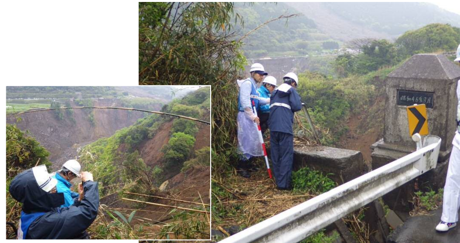
【法面崩落の調査(国道325号)】
