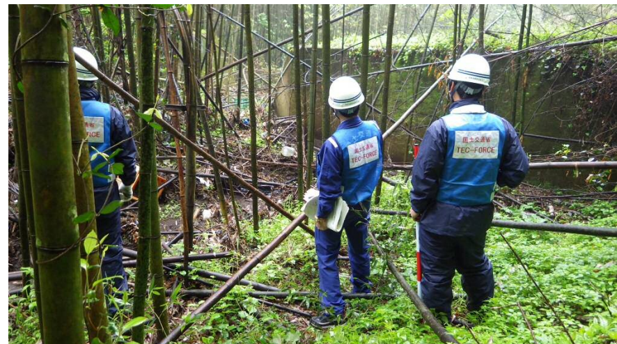
【高谷川砂防堰堤の調査】
