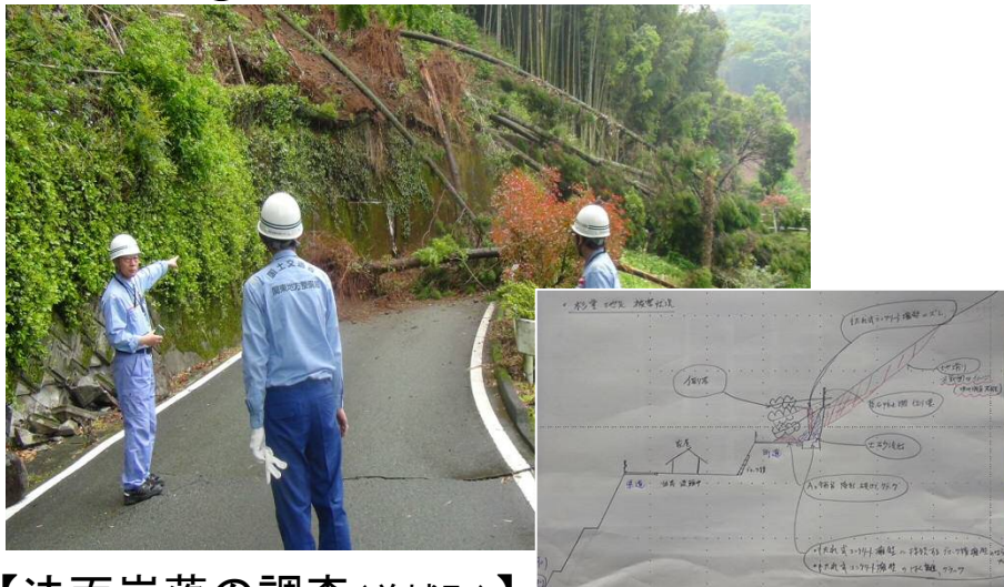
【法面崩落の調査(益城町)】
