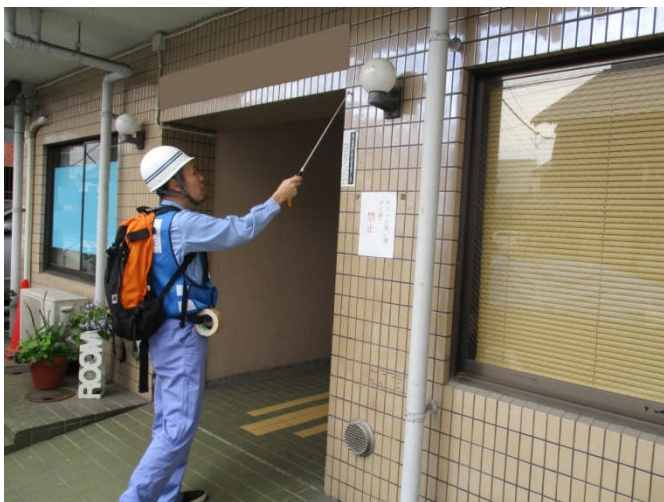
建物の応急危険度の調査
