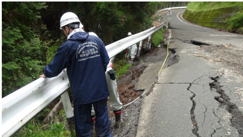
法面崩落箇所の調査(益城町)
