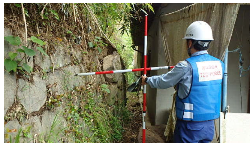
石積み擁壁の変状(宇土市)
