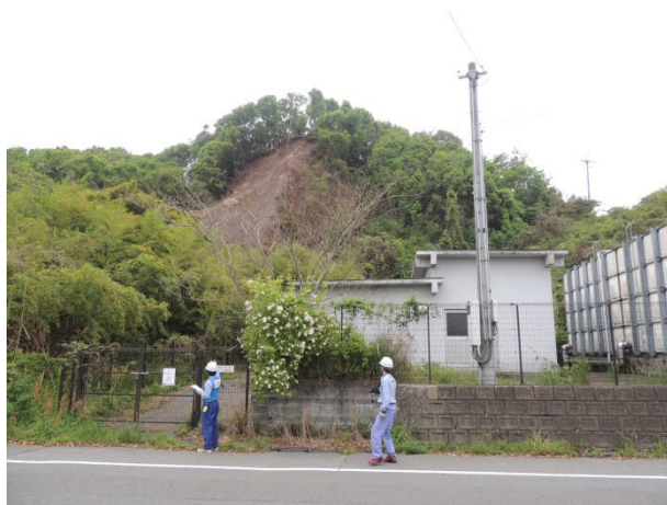
法面崩落箇所の調査(宇土市)
