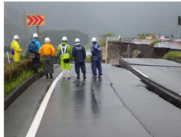
道路崩落箇所の調査(益城町)
