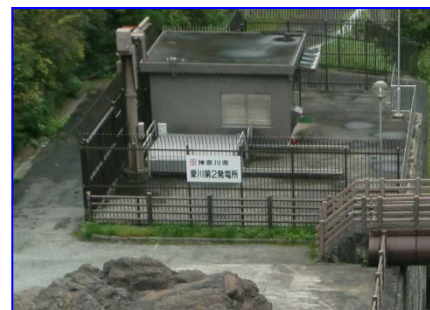
愛川第2発電所
