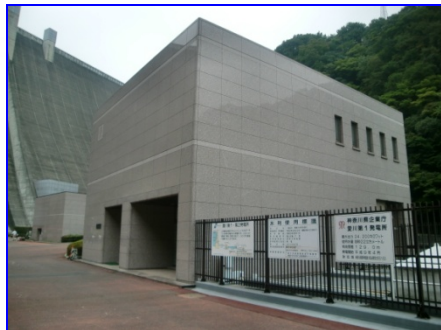
愛川第1発電所
