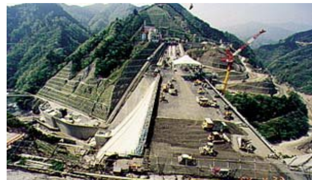
本体コンクリート打設状況
