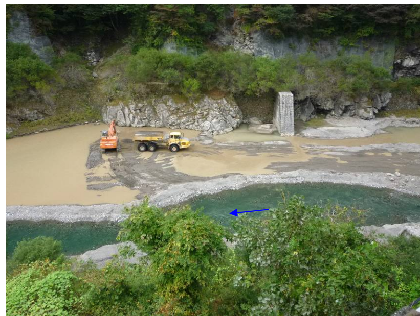
貯砂ダムと土砂掘削の状況
