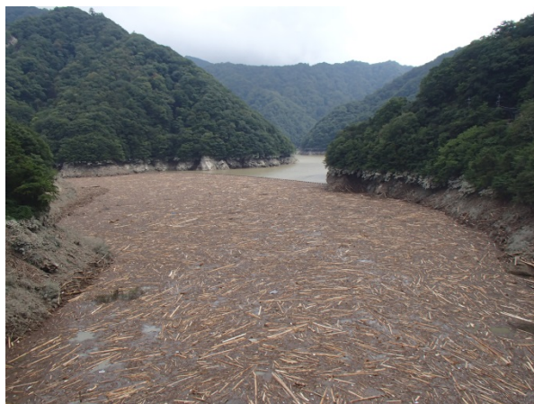
五十里ダムによる流木の捕捉状況 (H27.9.16)
