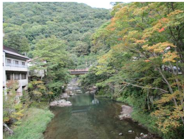
フラッシュ放流前の状況 (新男鹿橋) H26.9.25
