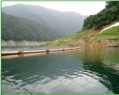
濁水拡散防止フェンス
