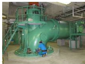
排水ポンプの振動計測
