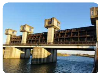
ゲート設備（福川水門）
