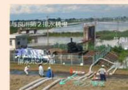
与良川から渡良瀬第2調節池（渡良瀬川）へ排水機場とポンプ車1台の共同にてポンプ排水
