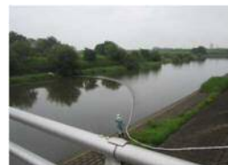
オイルフェンスの設置
