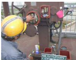
ゲート開閉装置のブレーキ点検
