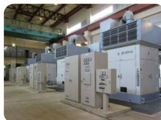
ポンプ設備（谷田川排水機場）
