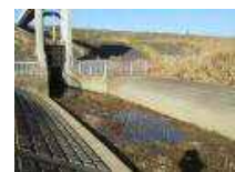
水路への土砂堆積
