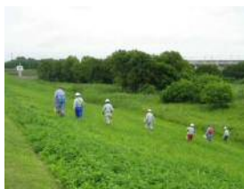
徒歩による堤防点検
