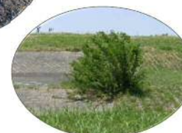
護岸に樹木繁茂
