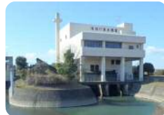
休泊川排水機場
