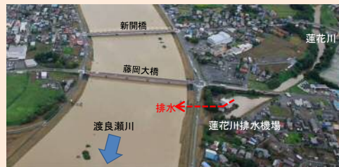
上空から見た排水運転中の蓮花川排水機場 (平成27年9月10日・栃木県栃木市)
