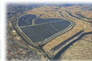
渡良瀬貯水池（谷中湖）干し上げ状況
