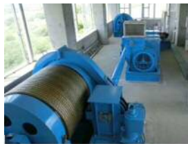
電気不要の予備動力を備えた開閉装置 (稲戸井排水門・茨城県)
