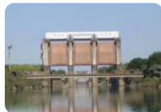
渡良瀬調節池第1排水門
