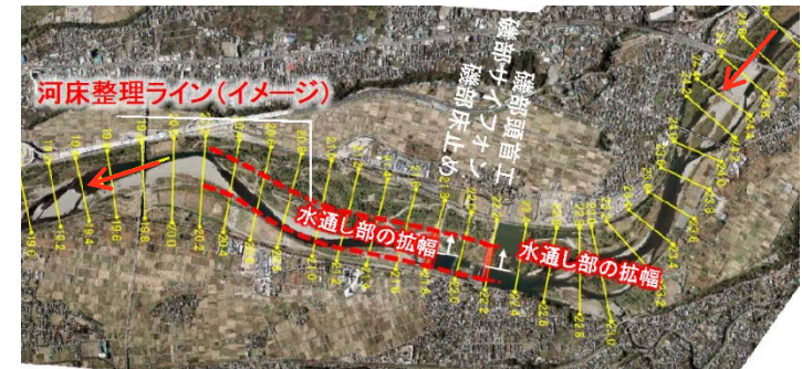
磯部頭首工、磯部床止めの改築
