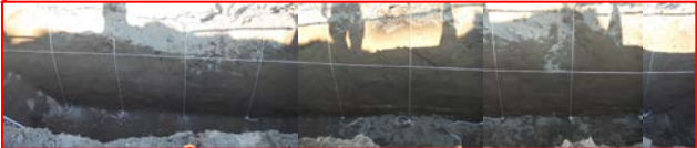
トレンチ掘削箇所
