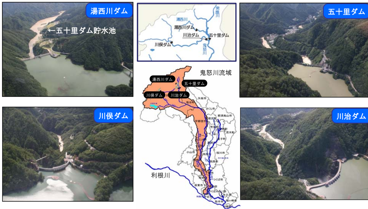
※各ダムの写真は、ダム上流側から9月11日に撮影
