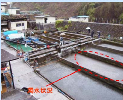
【養殖場の濁水により使用停止が発生】
