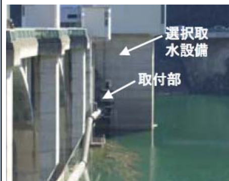
選択取水設備取付部
