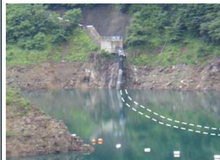
バイパス管浮遊管部
