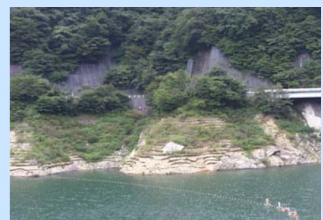
フェンス設置・植栽による対策
