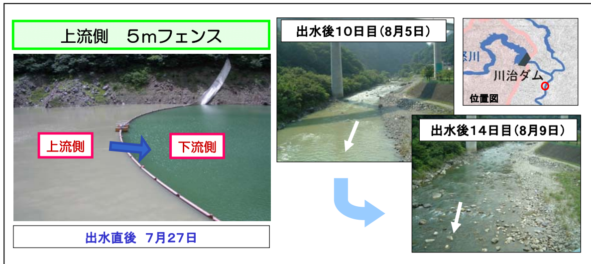
図5 汚濁拡散防止フェンスの設置効果
