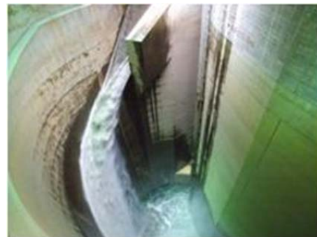
写真2 ドロップシャフトの 運用状況 (第3立坑)
