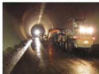
写真3 堆積土砂撤去状況
