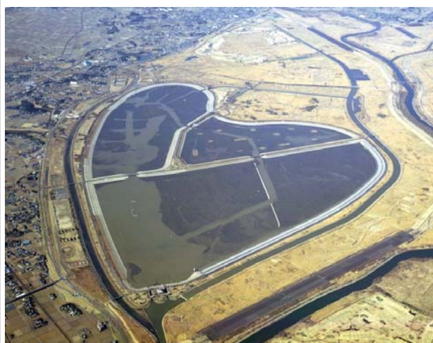
湖底の約80%を干し上げた状況：H18. 3撮影
