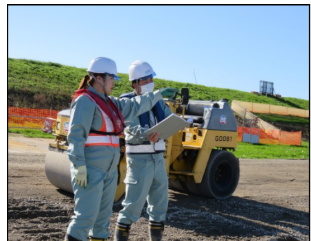
図-10 女性技術者登用モデル工事 (H26 行田低水護岸(下流)工事)
