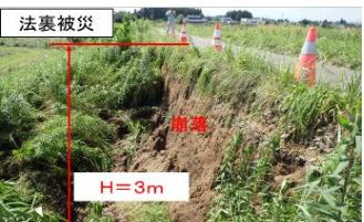
天端のアスファルト等が、越水による侵食から堤体を保護
