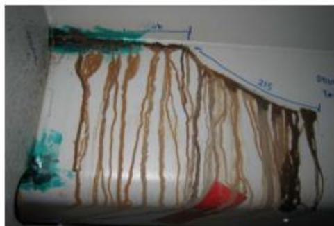
橋桁の内部へ進展した亀裂
