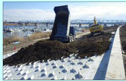
堤防復旧状況
