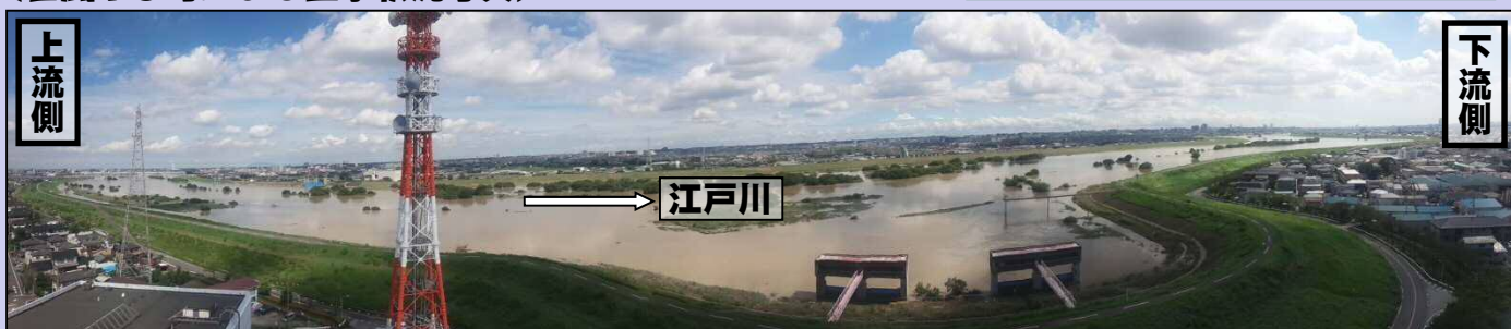
※9/11 三郷排水機場煙突より江戸川方面を撮影
