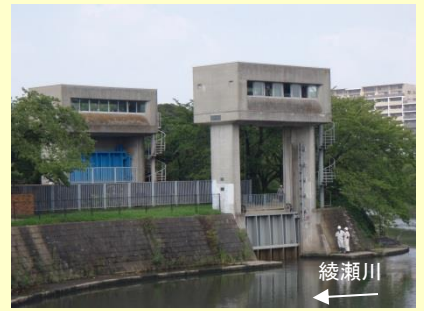
神明排水樋管
