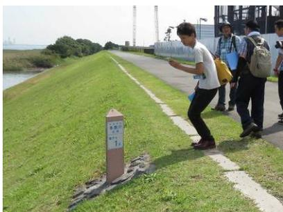
多摩川では 200m 毎にキロ杭（距離標）を設置しています。写真は多摩川の河口と定めている地点から 1km の地点に設置されているキロ杭です。
