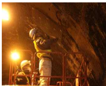
写真-2 新規施工技術調査
