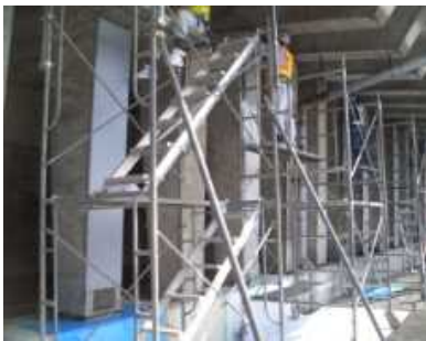
写真－1 試験施工状況
