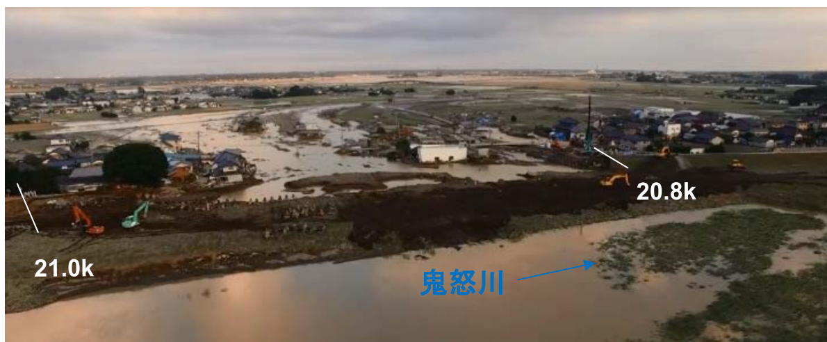
応急復旧状況(9/12)
