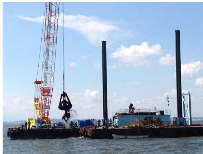
クレーン台船による流木の回収状況
