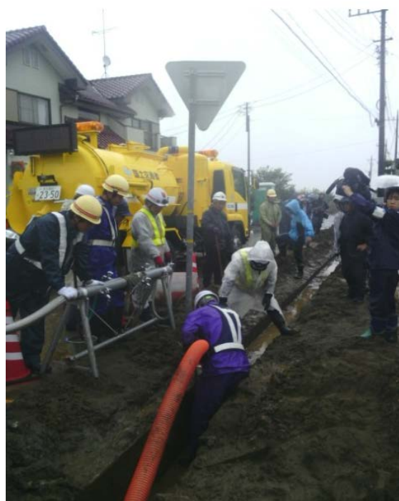
側溝清掃車による堆積土の撤去
