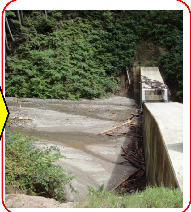
土石流発生直後 (H27.9.11)
