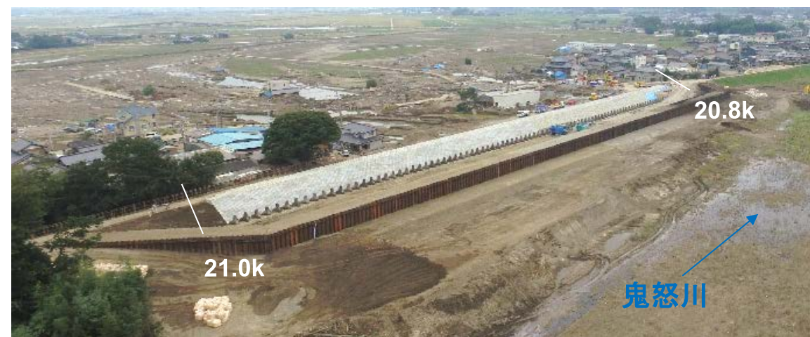
応急復旧状況(9/24)
