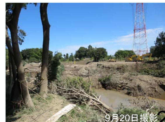
⑤溢水箇所(24.75k付近)排水後
