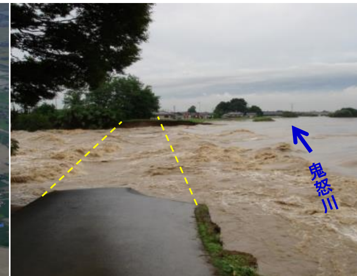
被災状況(拡大写真)
