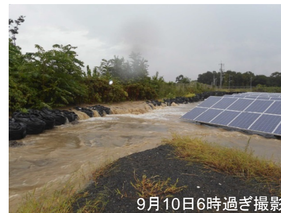
①溢水箇所(25.35k付近)溢水状況
