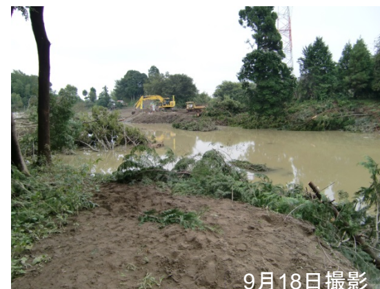
⑤溢水箇所(24.75k付近)排水前
