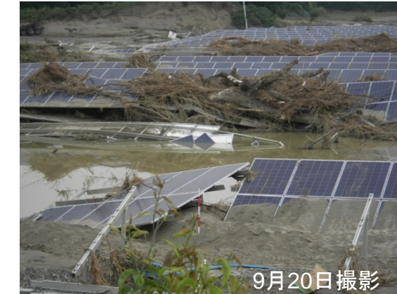
②溢水箇所(25.35k付近)被災状況
