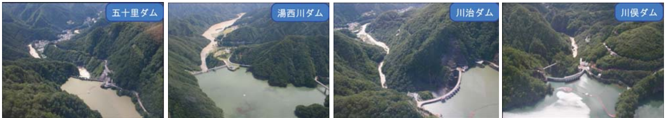
上記の4つのダムの写真は平成27年9月11日に撮影したものです。どのダムも満水であったことが一目でわかります。
