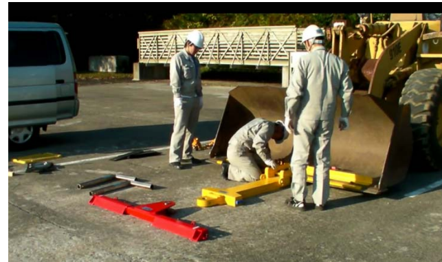
⑤補強材取付
