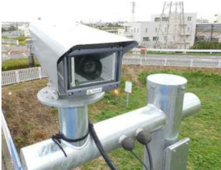
<CCTV：幸魂大橋>
