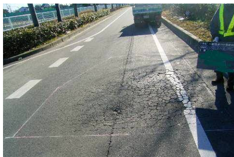
<路面異状確認>
