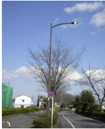
<道路照明：国道298号側道部>
