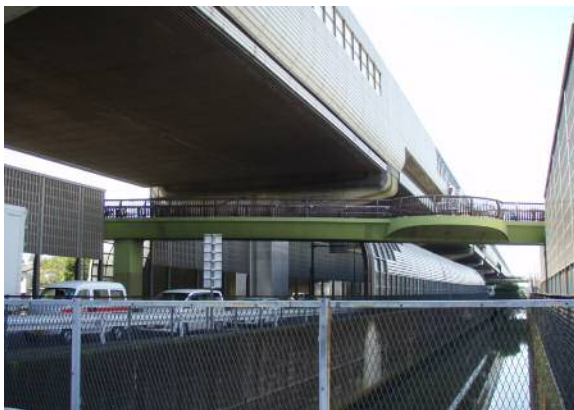
<岸川中学校前歩道橋>
