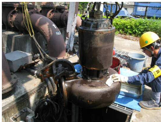
<排水設備（点検状況）>
