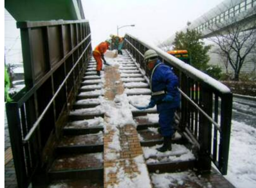
<歩道橋人力除雪>
