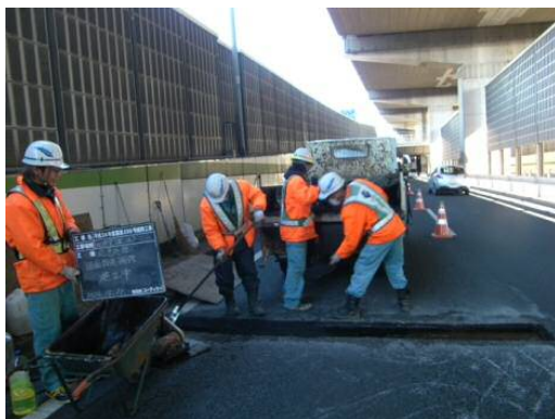
<路面段差補修>
