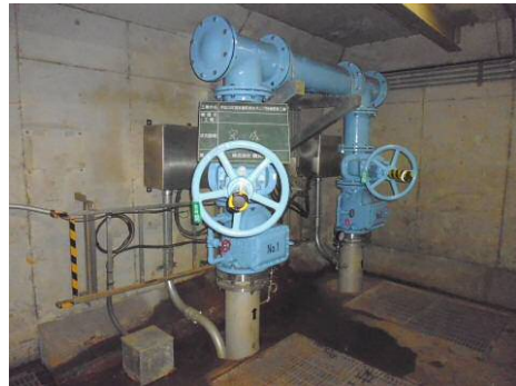
<道路排水設備：新善町 排水ポンプ>
