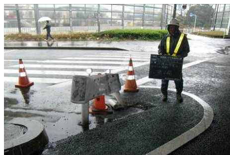
<ガードレール損傷確認>
