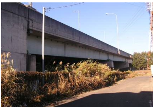
<全景：荒川右岸取付橋（上り）>
