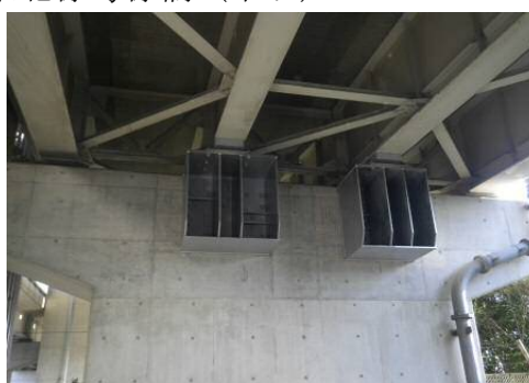
<耐震補強の例：変位制限装置>
