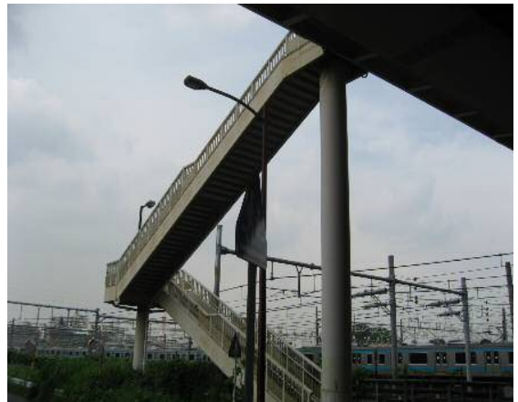
<人道橋：東北線跨線橋上り階段>
