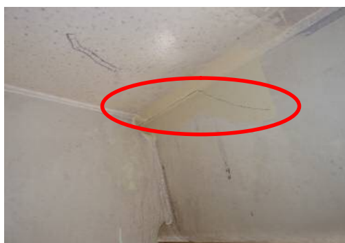
<ひび割れ箇所の例>
