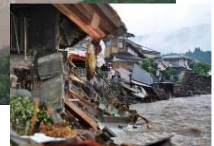
河岸侵食に伴う家屋倒壊
