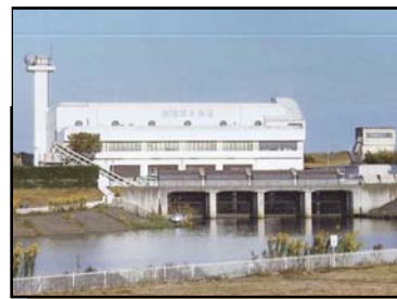
▲南畑排水機場
