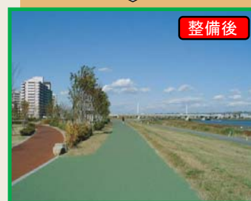
▲高規格堤防（小松川地区）
