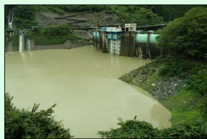
▲洪水後の濁水の長期化
