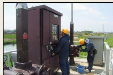
▲河川管理施設の点検状況
