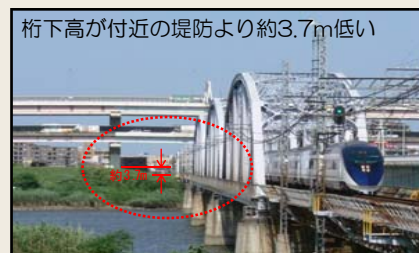
▲京成本線荒川橋梁
