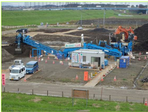
万能土質改良機による土砂改良 (混合)状況の様子:H27.11.18撮影
