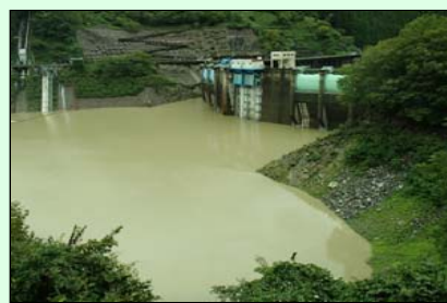
▲洪水後の濁水の長期化
