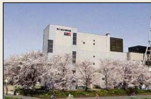
▲荒川知水資料館
