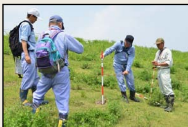
▲堤防点検状況
