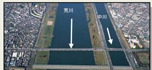
▲放水路区間 (下流部)
